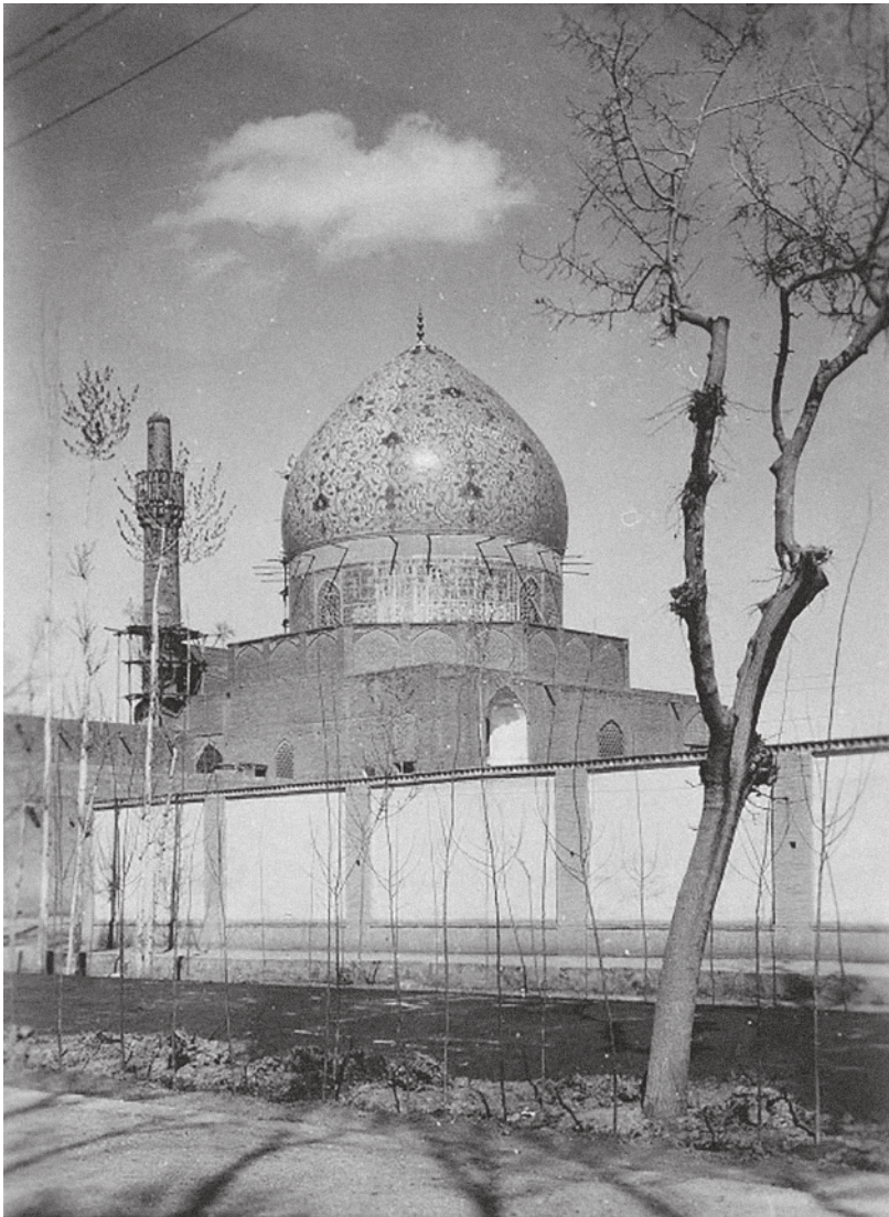
خیابان چهارباغ عباسی، اوایل دوره پهلوی، قبل از احداث خیابان آمادگاه
