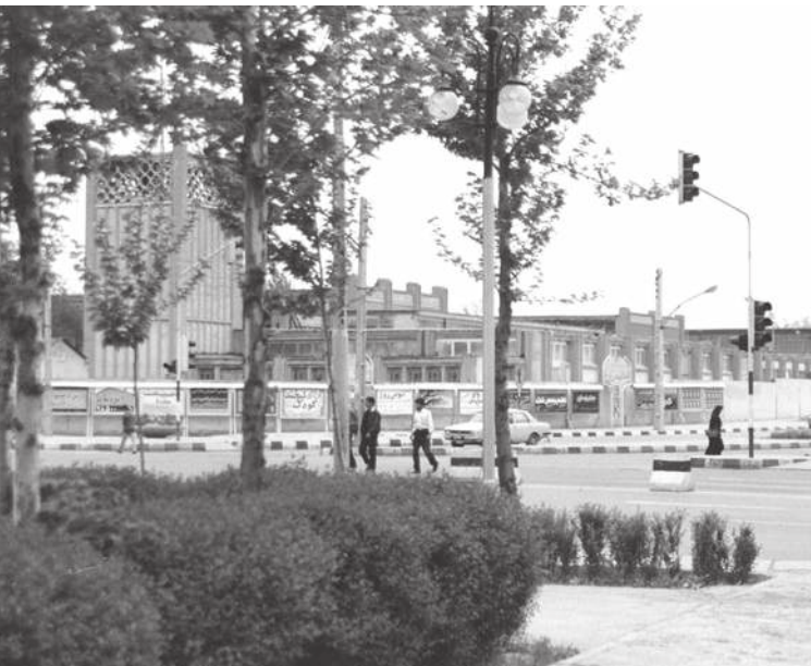
کارخانه زاینده رود در کنار رودخانه زاینده رود و پل فردوسی چندماه قبل از تخریب (عکس از مهندسان پلشیر)
